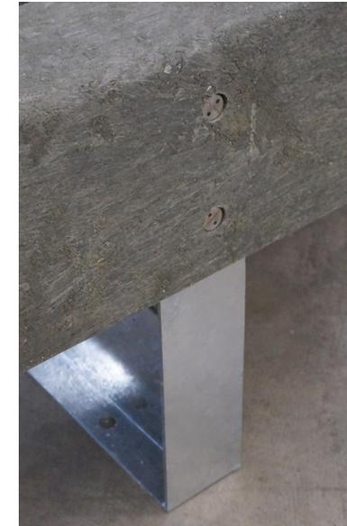
Detail Streetlock® Diebstahlsicherungsnüsse
